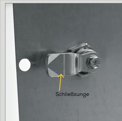
8. Positionieren Sie die Schließzunge so auf den Drehriegelverschluss, dass sich die Schließzunge in Richtung der vorhandenen Lochung ausrichtet. Somit ist sichergestellt, dass die Schließzunge in den Profilrahmen der PowerBase verriegelt.
