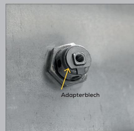
7. Stecken Sie das Adapterblech auf das vierkantige Ende des Drehriegelverschlusses.
